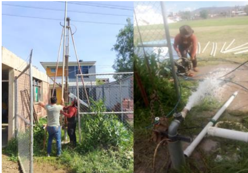
Servicio de limpieza de pozo en Stadium Samancha Urabi
