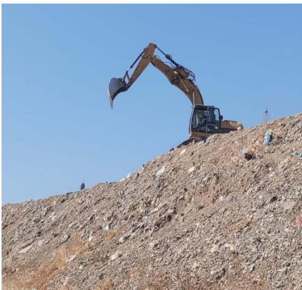
Reubicación de residuos sólidos para la conformación de las banquetas intermedias de las macro celdas 1 y 2.
