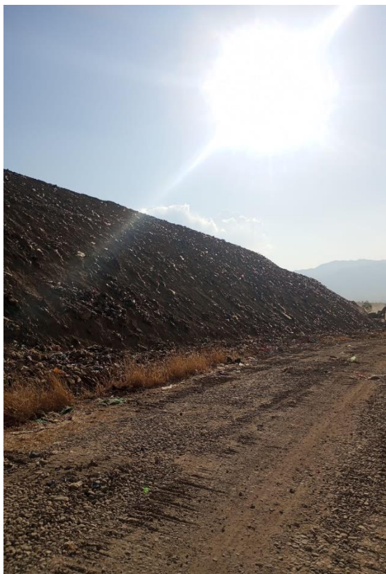
Afinado del talud intermedio de las macroceldas 1 y 2..
