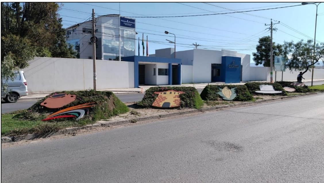
MEJORAMIENTO DE JARDINERA CENTRAL AV. COLCAPIRHUA (VICTOR USTARIZ).
