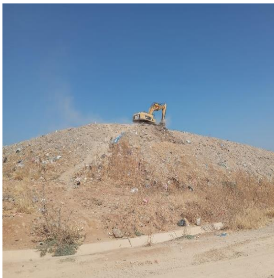
Afinado y peinado del talud de la macro celda 1.
