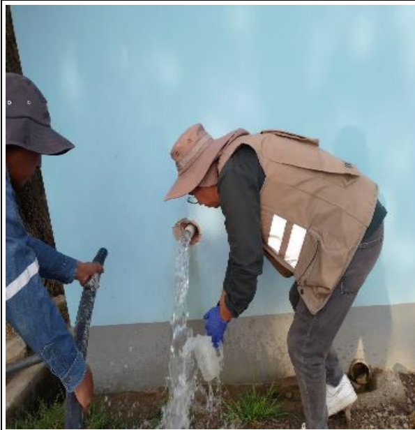
MONITOREO AL POZO DE AGUA DE COLCAPUJLLAY
