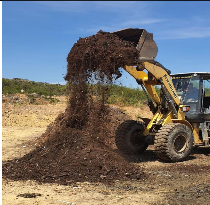
VOLTEO DE PILAS.
