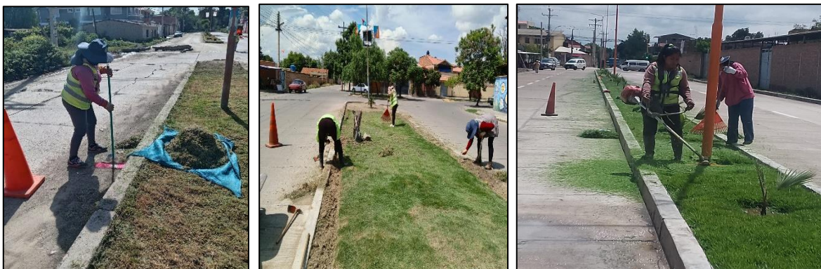
Mejoramiento y Mantenimiento permanente de Calles y caminos del Municipio de Colcapirhua.
