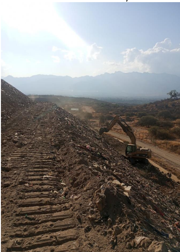
Afinado del talud intermedio de las macroceldas 1 y 2.
