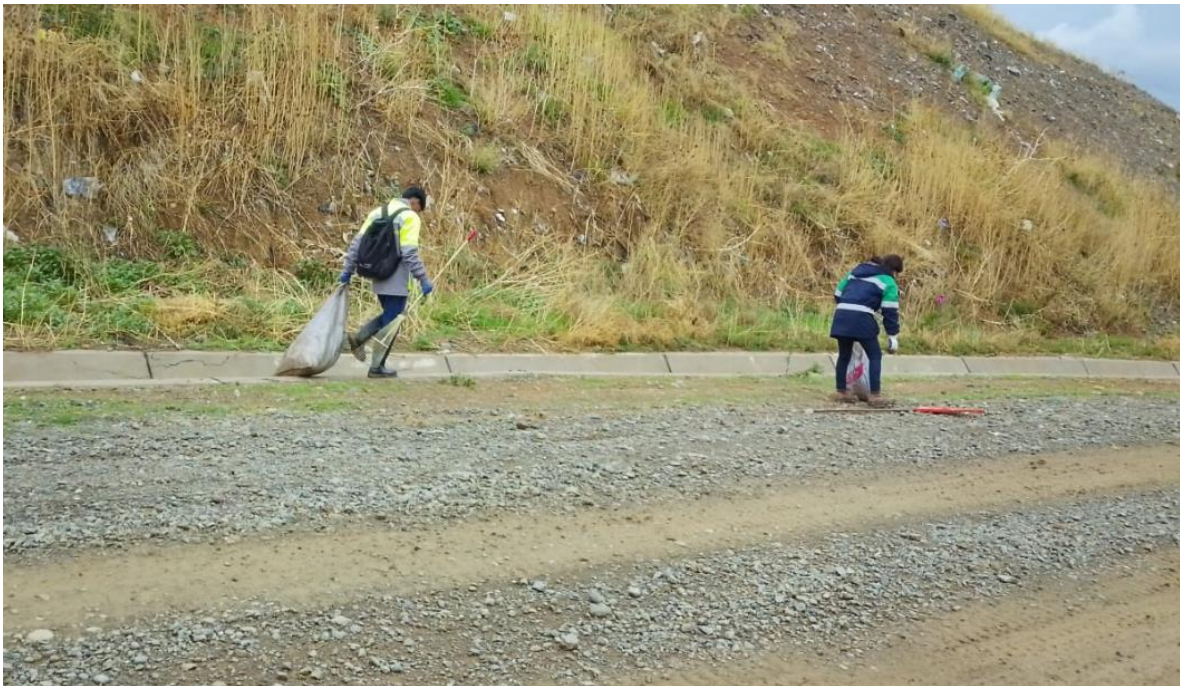
Limpieza de los canales de drenaje
